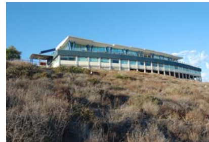
Vista exterior del edificio de Telemática
